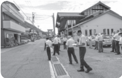
公共施設等適正管理推進事業 町道茂原・道口線舗装補修工事現場
