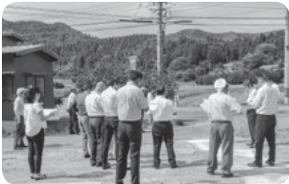
公共施設等適正管理推進事業 町道寺・八田線舗装補修工事現場
