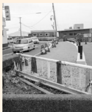
国道305号米ノ地区道路改良工事
