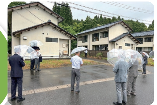
西多古団地改修工事
