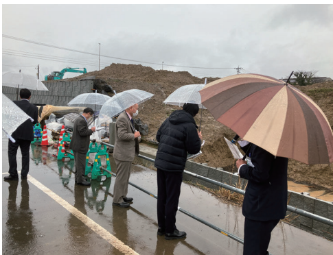
町道宝泉寺グラウンド線 道路改良工事 (天王地係)
