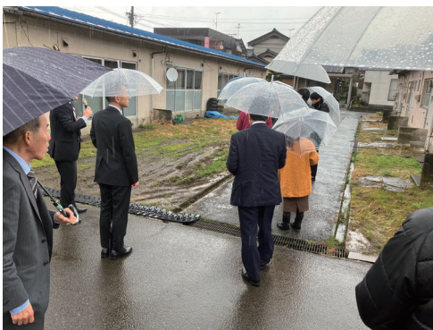
町営住宅上川去団地 解体工事 (上川去地係)
