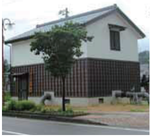
農業用水を安定供給する「櫻津揚水機場」
