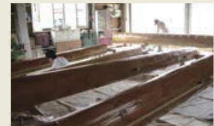
巨大な柱の塗装作業
