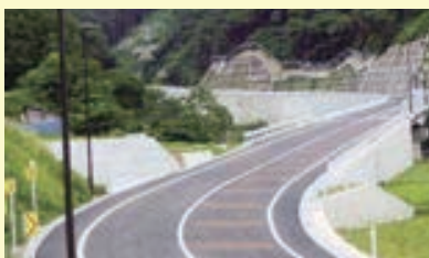
梅浦バイパス(国道365号)が開通
