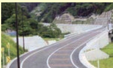
梅浦バイパス(国道365号)が開通
