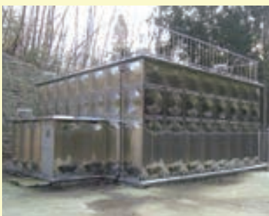
水の安定供給を目指し増設された惣分谷浄水場
