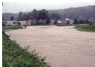
水位が上昇した天王川（平成18年7月）
