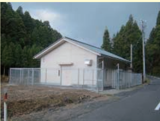
森配水ポンプ場
