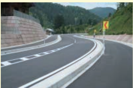
国道417号 青野鎌坂バイパス
