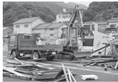
越前地区建設業会による道路啓開訓練
