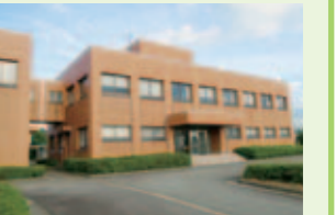
設備を改修した朝日浄化センター
