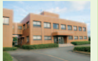
設備を改修した朝日浄化センター
