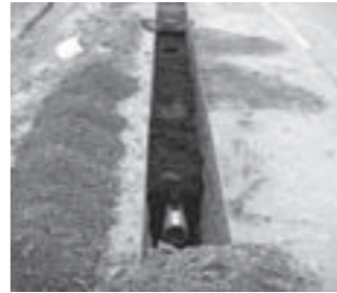
公共下水道につなぐ管路の布設
