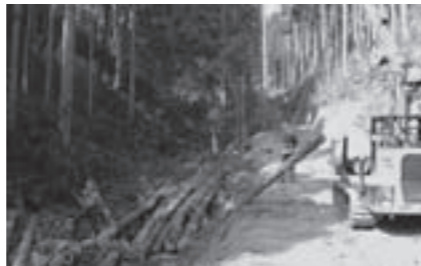
整備した作業路による森林施業
