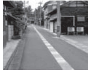
消雪設備が整備された町道（西田中地区）
