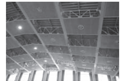
吊り天井となっている朝日小学校体育館
