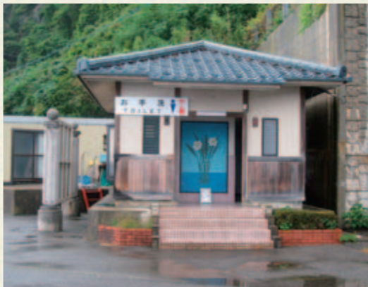
洋式トイレに改修（写真は玉川公衆トイレ）
