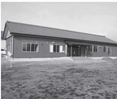
▲新築された乙坂自治会館
