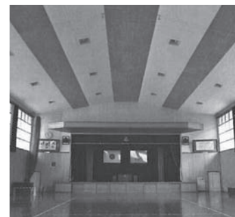
(工事後) ▲地震により落下する危険がある天井を改修(城崎小学校)▲ (工事前)
