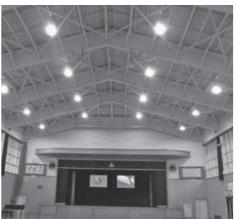
(工事後) ▲地震により落下する危険がある天井を改修(城崎小学校)▲ (工事前)
