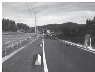
▲歩行スペースの設置による安全の確保(町道福井線)
