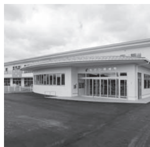
▲保育所統合により新築されたあさひ保育所
