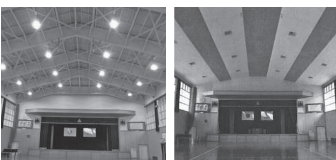
(工事後) ▲地震により落下する危険がある天井を改修(城崎小学校)▲ (工事前)
