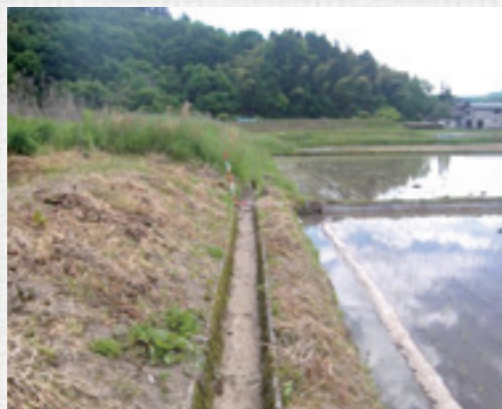
老朽化した用水路を改修
