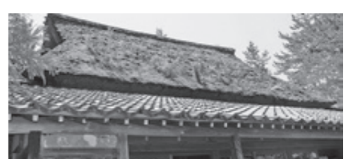
▲修繕工事前の相木家住宅
