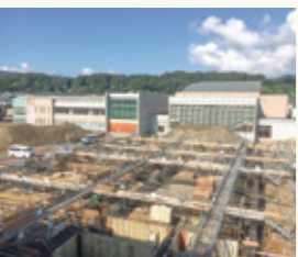
▲建設中の新庁舎
