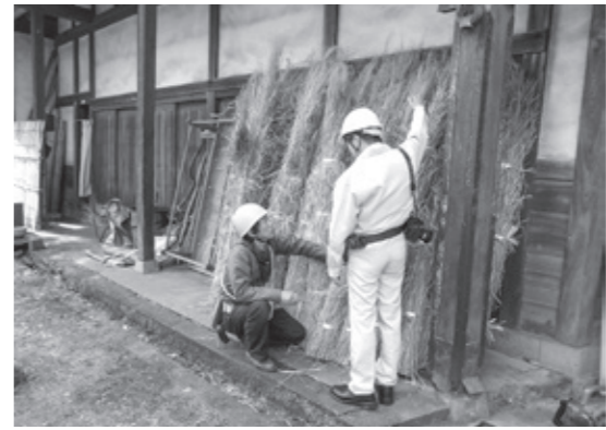
▲設計監理者 (ONO 建築設計工房) と技術指導者 ((公財) 文化財建造物保存技術協会) による材料検査 (山茅)
