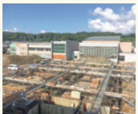
▲建設中の新庁舎
