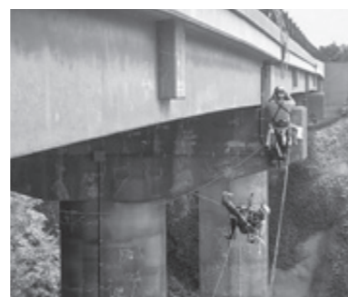
ロープアクセスによる点検 町道越前岬線 水仙橋
