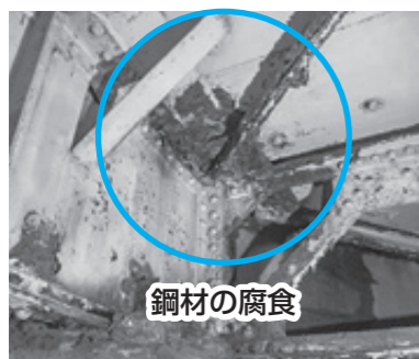
鋼橋の損傷状況 国道8号 鳩原跨線橋
