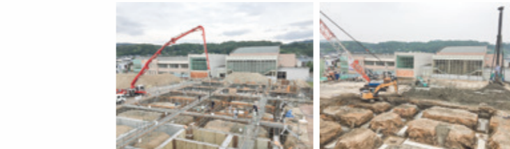
打ち終わった杭の上部に、補強筋を設置しました。また、杭頭との間にも鉄筋を組み、地中梁を設置しました。その後は、鉄骨建て方に向け、土の埋戻しを行いました。 (令和元年8月22日撮影)
