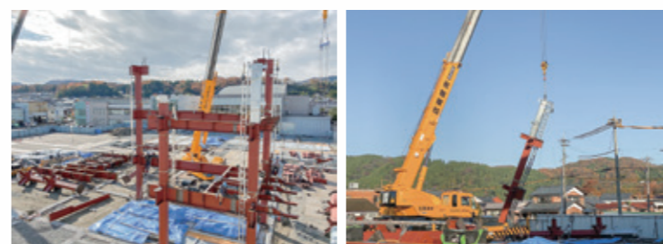
鉄骨の建て方工事を開始しました。2台のクレーンを使って順番に組立てていきました。 (令和元年11月29日撮影)
