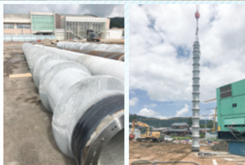
新庁舎と、渡り廊下部分に、基礎杭を65本打ちました。3本の杭を継ぎ足し、一番深い箇所まで33メートル地中まで打ち込んでいます。杭は太い物で、直径80センチあります。 (令和元年6月26日撮影)
