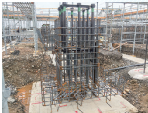
打ち終わった杭の上部に、補強筋を設置しました。また、杭頭との間にも鉄筋を組み、地中梁を設置しました。その後は、鉄骨建て方に向け、土の埋戻しを行いました。 (令和元年8月22日撮影)
