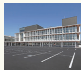
▲完成した役場新庁舎
