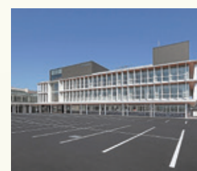
▲完成した役場新庁舎
