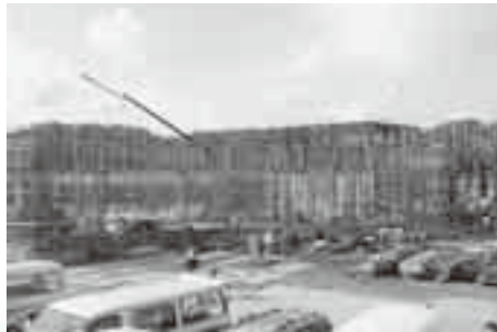
朝日中学校建設現場
