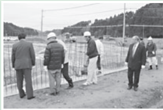
（仮称）鯖江・丹生消防組合丹生分署建設現場
