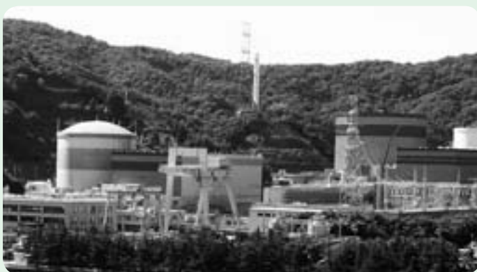
敦賀原子力発電所
