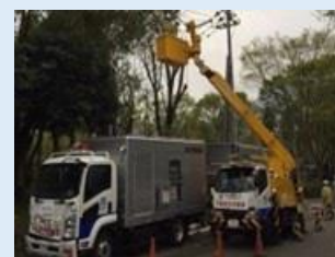
災害時の停電復旧作業
