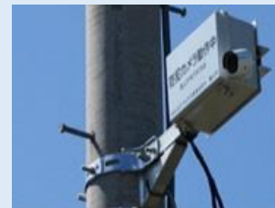
防犯カメラ設置
