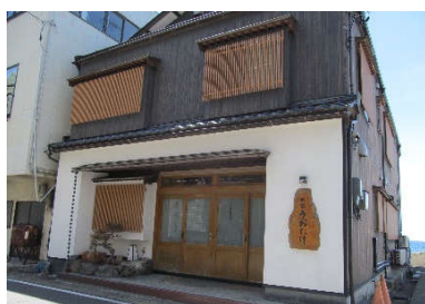
自然素材を用いた建築物の例
