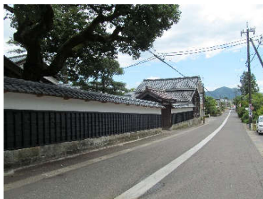
伝統的な建築物と調和した塀の例
