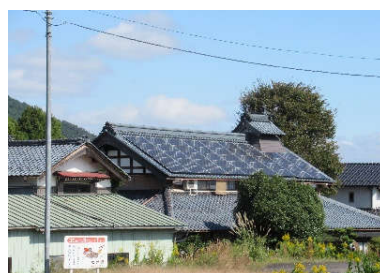
屋根と一体的に感じられる太陽光発電設備のパネルの例
