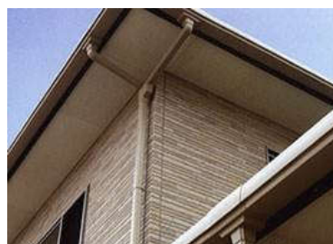
給排水管（雨どい）の色彩を外壁と揃えて目立ちにくくしている例
