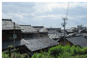
屋根向きが揃った家並みの例
