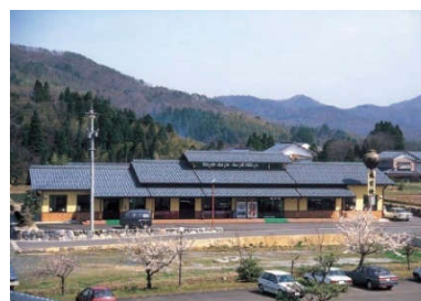
勾配のある銀ねず色の越前瓦葺の建物の例
