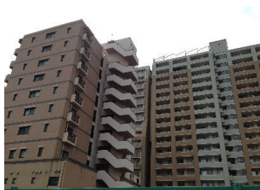
屋外階段を外壁と同じデザインで揃え、建築物との一体性をもたせている例
