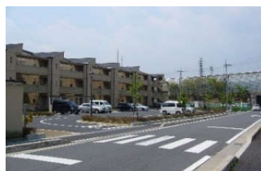
長大な壁面にならないように壁面を分節化し、色彩の組み合わせを工夫している例
