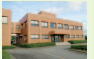
設備を改修した朝日浄化センター
