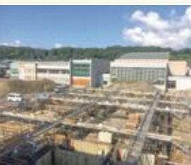
▲建設中の新庁舎
