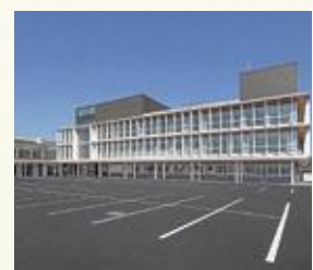
▲完成した役場新庁舎
