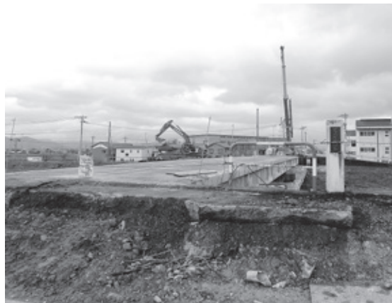
天神橋架け替え工事現場踏査
