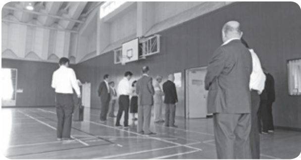
B & G 体育館改修工事現場
