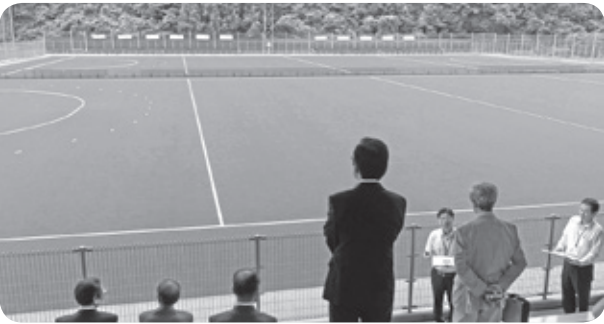
町人工芝サッカー場改修工事現場
