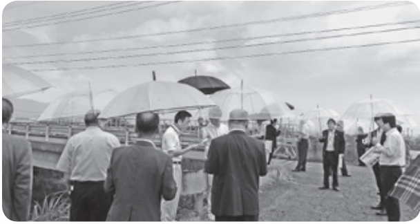
町道西大井線道路改良工事現場
