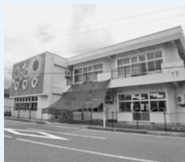
解体予定の旧織田児童館
