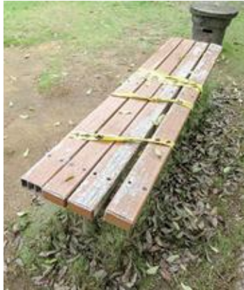
破損した木製ベンチ
