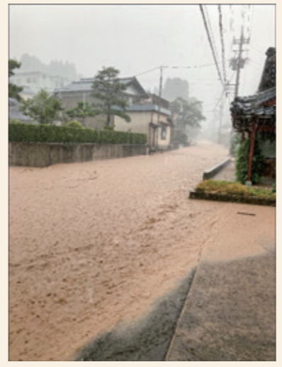
▲町道栃川線（栃川）の冠水の様子
