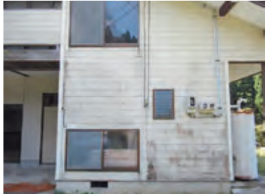
南団地(2階建)の外壁
