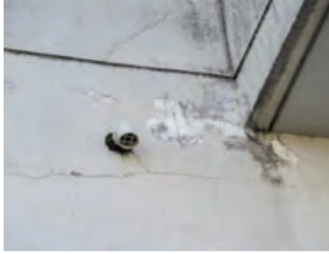
朝日団地(A棟)の外壁
