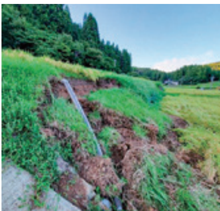
畦畔崩壊による被害（中野地係）
