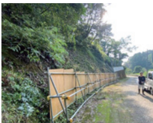
道路改修箇所（町道 小樟城ヶ谷線）
