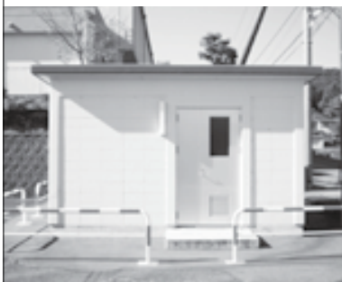
流量調整弁室
