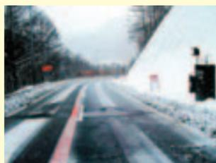
凍結防止剤自動散布装置設置イメージ
