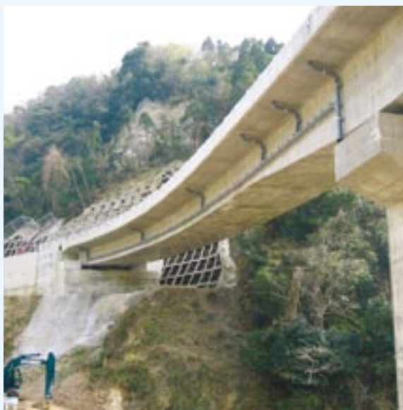
国道 365 号線 高架部分
