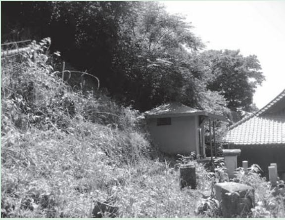
急傾斜地崩壊対策工事実施箇所
