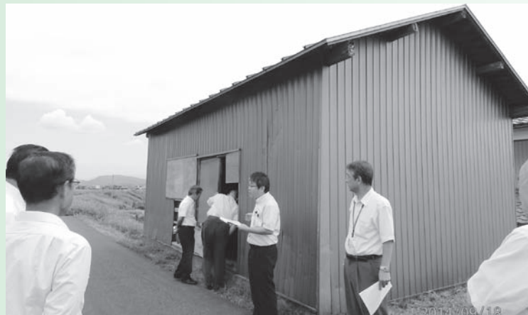
解体する消防水防倉庫
