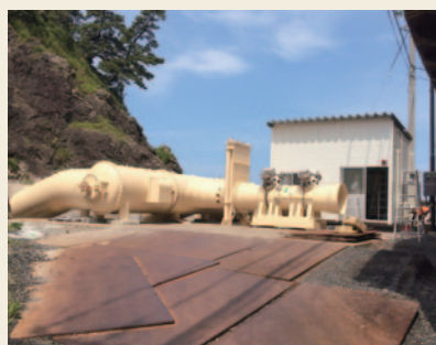
世界初のブローホール式波力発電研究設備
