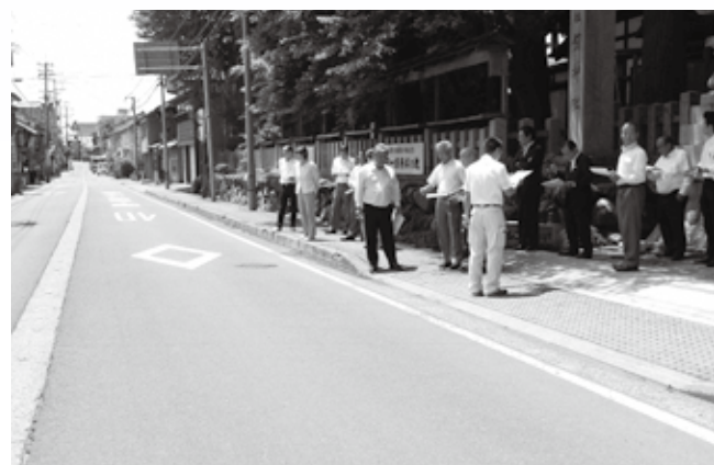
劔神社前通りの消雪施設の工事現場
