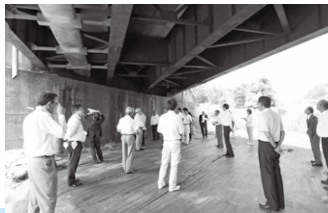
長寿命化を図るための橋梁補修工事現場
