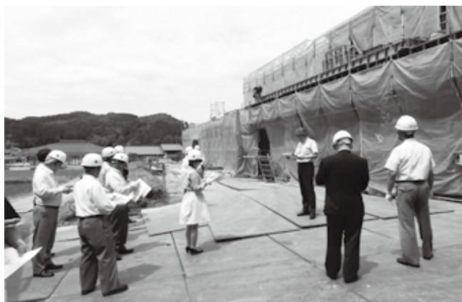
統合学校給食センターの建設事業現場
