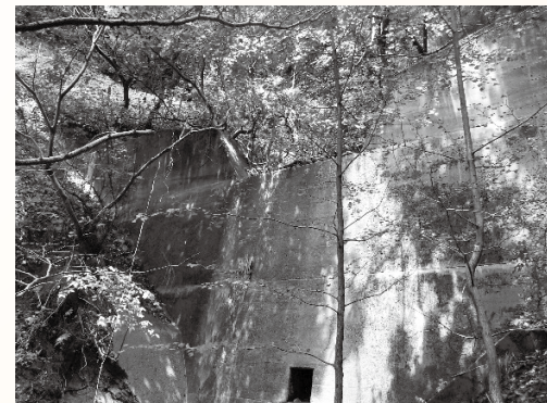
既設治山ダム
