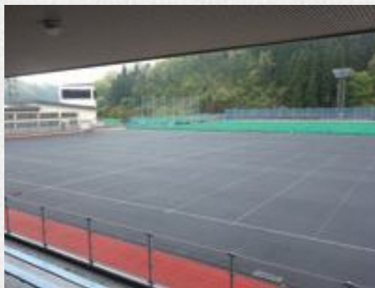
人工芝の張替え工事が進む越前町人工芝ホッケー場
