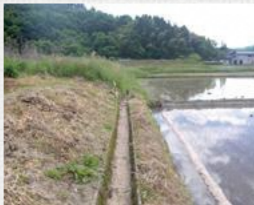
老朽化した用水路を改修
